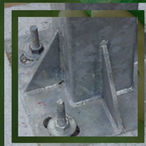
Reparación y Anclaje
