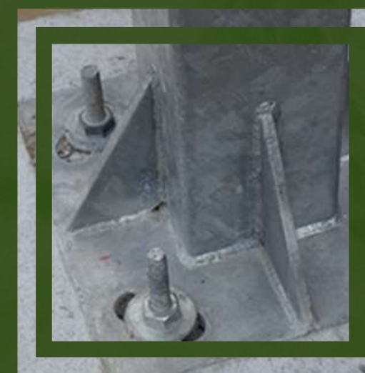
Reparació i Anclatge
