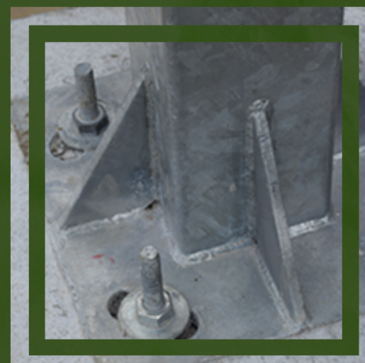
Reparación y Anclaje
