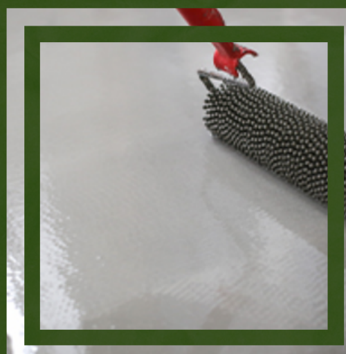
Pavimentos y Recrecidos
