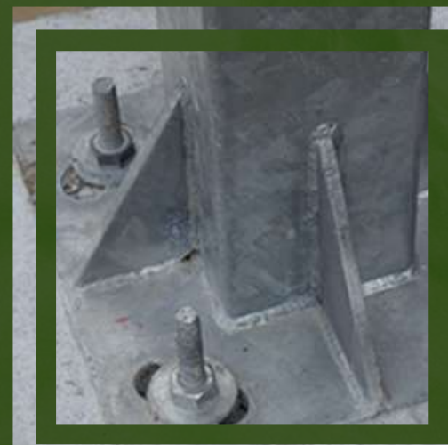
Reparació i Anclatge
