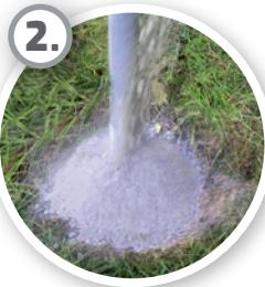
2. Centrar bien el objeto a fijar en el orificio y verter el producto hasta aproximadamente 1/4 de la profundidad del orificio, añadir agua con una regadera con alcachofa hasta que esté saturado, verter el resto del producto repartiéndolo uniformemente por todo el orificio.
